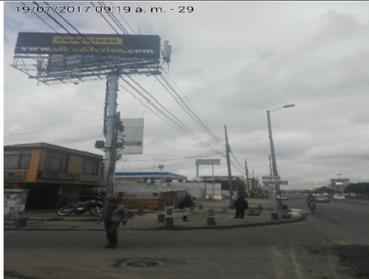
FOTOGRAFIA 1: Vista panorámica del elemento instalado en la AVENIDA CARRERA 72 No. 68 B - 90
