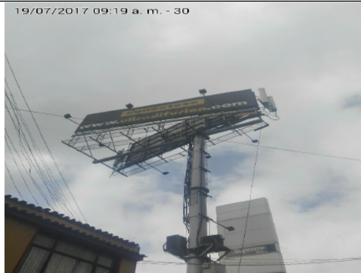
FOTOGRAFIA 2: Foto del tablero de la valla tubular instalada en la AVENIDA CARRERA 72 No. 68 B - 90
